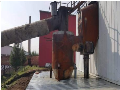
Ангилал : 3-7. Газан зуухны боллон будаж засварлав. Газан зуухны боллон болон шугаман хоолойн дулаалаг .
