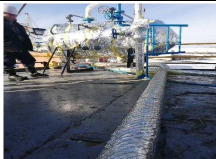
Ангилал : 3-7. Газан зуухны боллон будаж засварлав. Газан зуухны боллон болон шугаман хоолойн дулаалаг .
