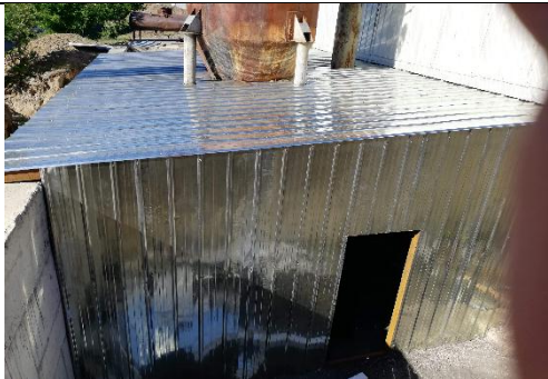
Ангилал : 3-6. Газан зуухны усан хаалттай лаг гоождог 2 яндан мөн тунель зуухруу хий дамжуулдаг1000-ын хоолойг ухаж цэвэрлэж дуусгасан,
