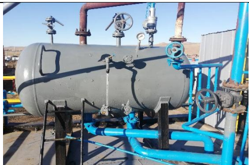
Ангилал : 3-7. Газан зуухны боллон будаж засварлав. Газан зуухны боллон болон шугаман хоолойн дулаалаг .
